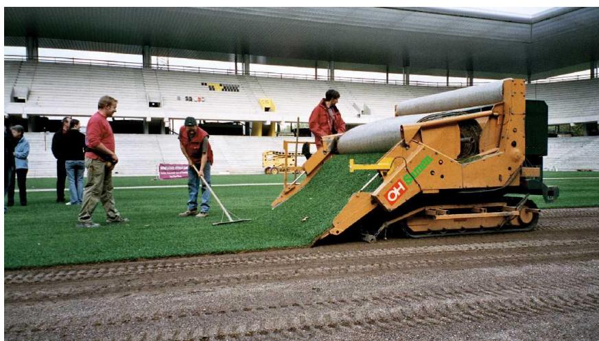
Sanft und exakt geführt gleitet die Jumbo-Rolle als Rasenteppich über den Tisch der Verlegemaschine auf die Rasentragschicht
