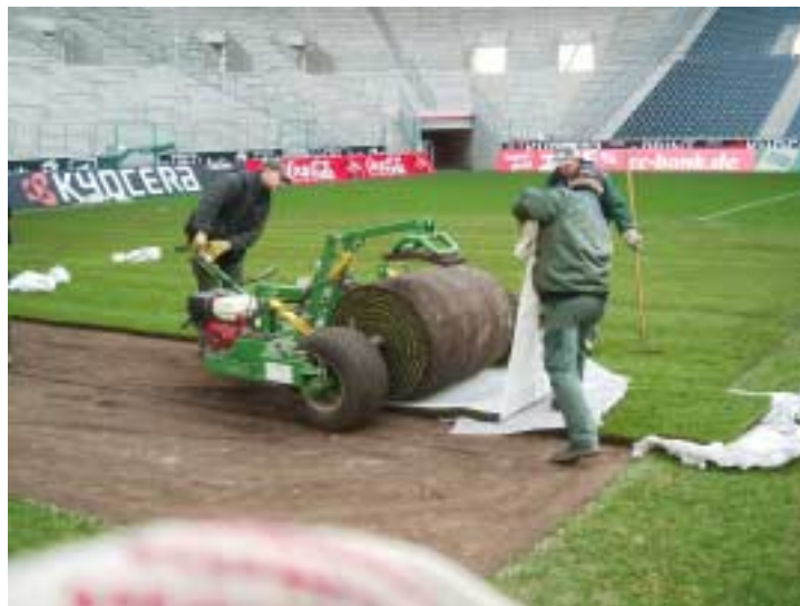
Abb. 4: Verlegung einer „Dicksode“ mit Spezialgerät zum Rasentausch im Strafraum eines Stadionrasens, Foto: Th. Pasch
