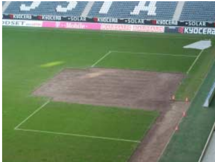
Abb. 3: Entfernung des Rasens bei stark geschädigten Teilflächen (z.B. Strafraum) zur Vorbereitung auf die Verlegung einer „Dicksode“, Foto: Th. Pasch
