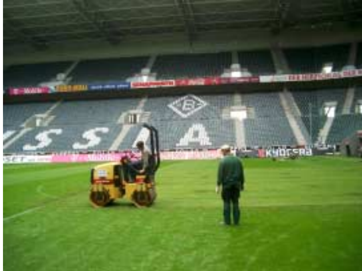
Abb. 5: Abschließendes Anwalzen einer frisch verlegten „Dicksode“, zur Vermeidung von Fugenbildung und Erhöhung der Ebenflächigkeit, Foto: Th. Pasch
