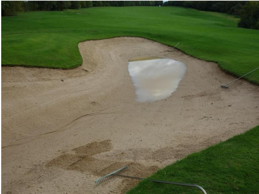
Abb.3: Fehlende Funktionsfähigkeit der Dränage im Bunker (Foto: H. SCHNEIDER).
