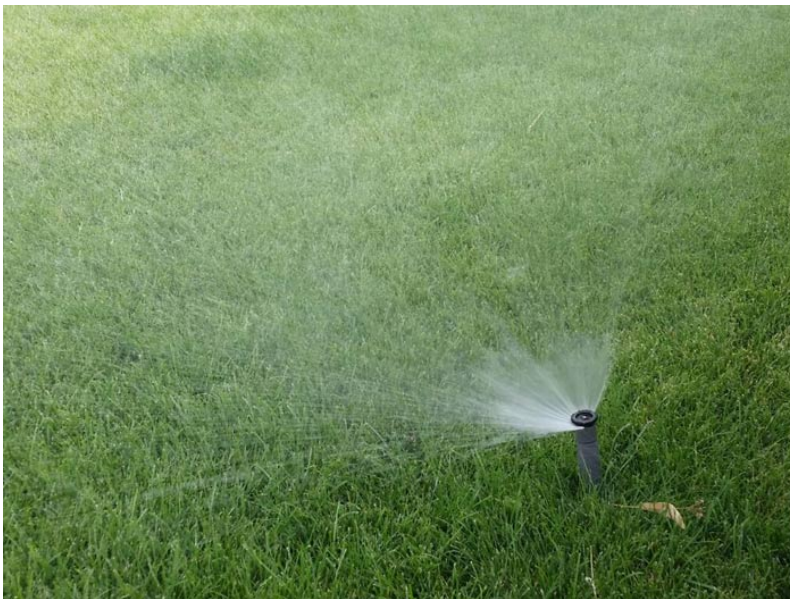
Foto 5: Komfortabel: Versenkberegnung im Hausrasen (Foto: Dr. H. Nonn)
