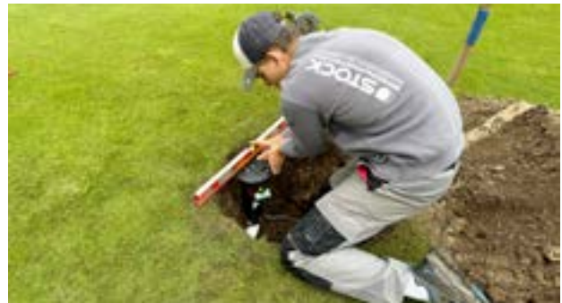
Austausch eines Regners mit Umrüstung auf ein digitales Steuersystem
