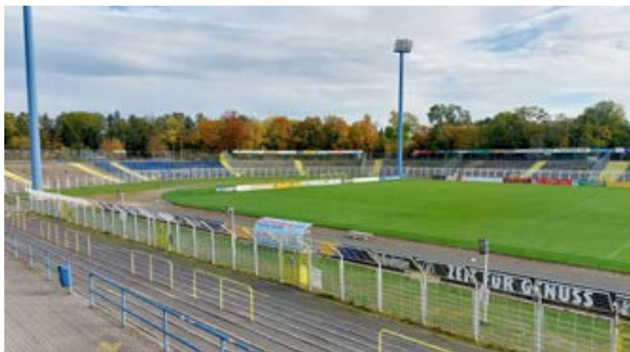
Das in der Sanierung befindliche Bruno-Plache-Stadion von LOK Leipzig. (Foto: G. Bischoff)
