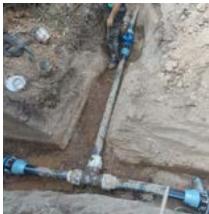
Erneuerung der Absperr-Schieber
