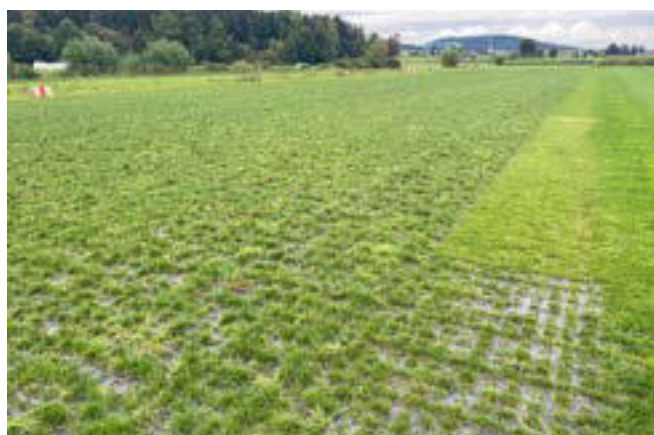
Foto 7: Rasengitter-Armierung der Rasenpiste am Flugplatz Luzern-Beromünster
