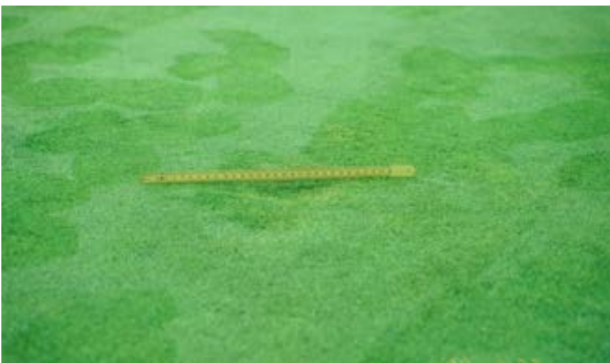
Deutliche Absenkung im Bereich eines Flecks
