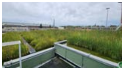
Abb. 1: Pflanzenkläranlage im John Deere-Werk Mannheim. (Foto: M. Karle)
