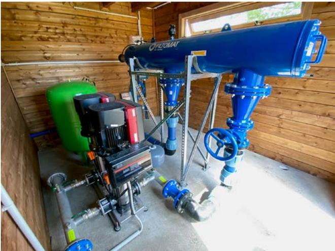
Abb. 4: Pumpenanlage mit Siebfilter
