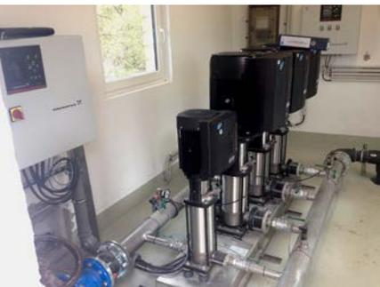
**Abb. 2: Frequenzgesteuerte Pumpen- bzw. Druckerhöhungsanlage**
