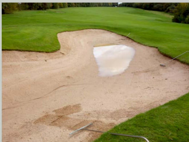
Abb. 2: Fehlende Funktionsfähigkeit der Dränage im Bunker
