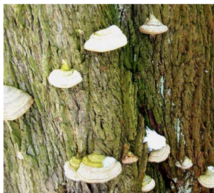
Abb. 11: ... und die des „Zunderschwammes“ müssen beachtet und angemessene Maßnahmen eingeleitet werden.
