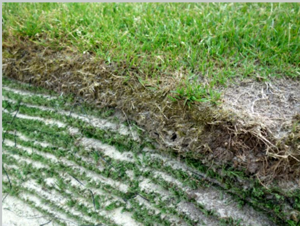
Abb. 1: Revetted Bunker mit Kunststoffrasen
